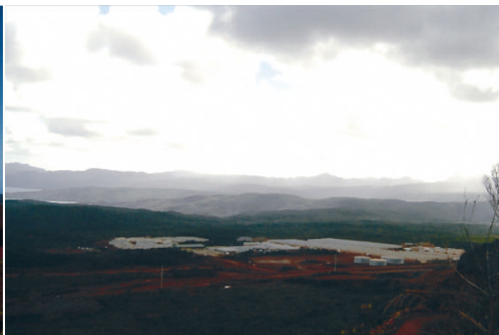
2 - Vue de l'usine de traitement du nickel en cours de construction
