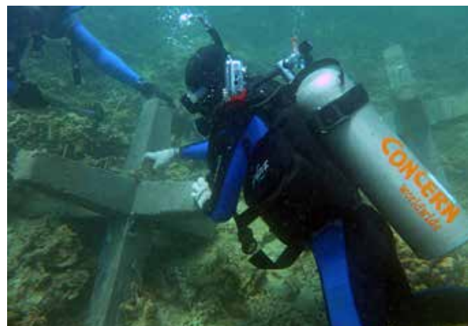
7c Mise en place des tétrapodes
