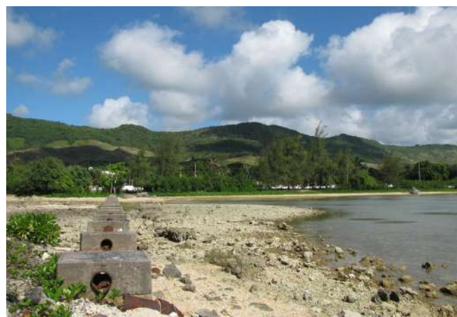
Ancien tuyau, source de pollution ?
