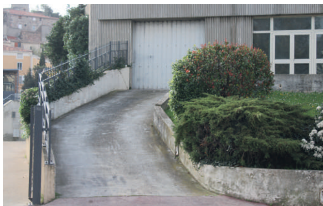
Une rampe permet l'accès aux voitures pour un déchargement rapide
