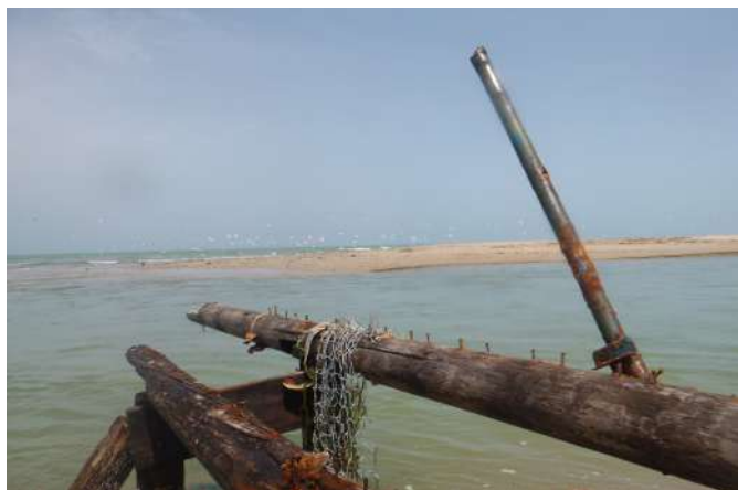
Passerelle emportée par le courant
