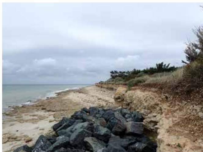
Enrochement exogène rapporté sur littoral charentais (roches calcaires ou diorite)
