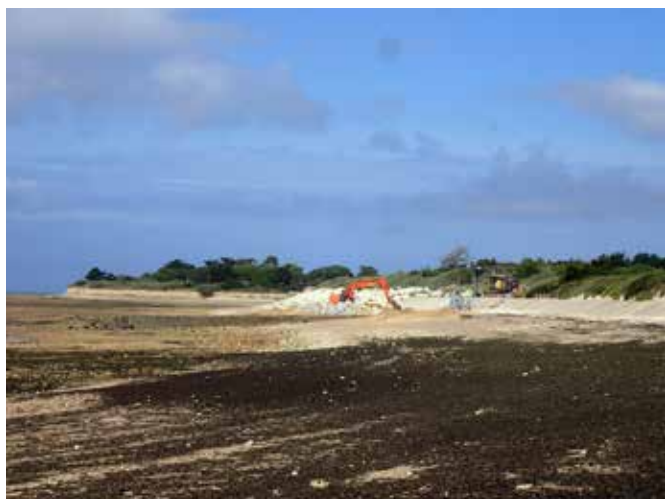
Enrochement exogène rapporté sur littoral charentais (roches calcaires ou diorite)
